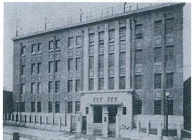
完成した本校舎（1932年）
